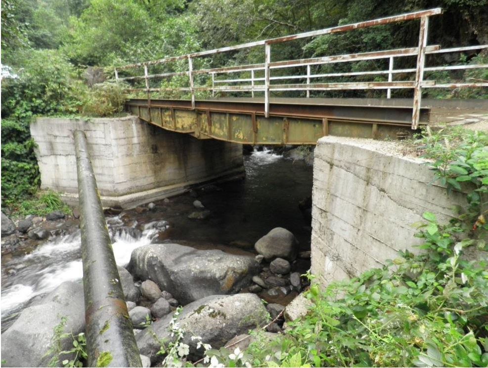
Вживаний залізничний міст, встановлений на лісовій дорозі
