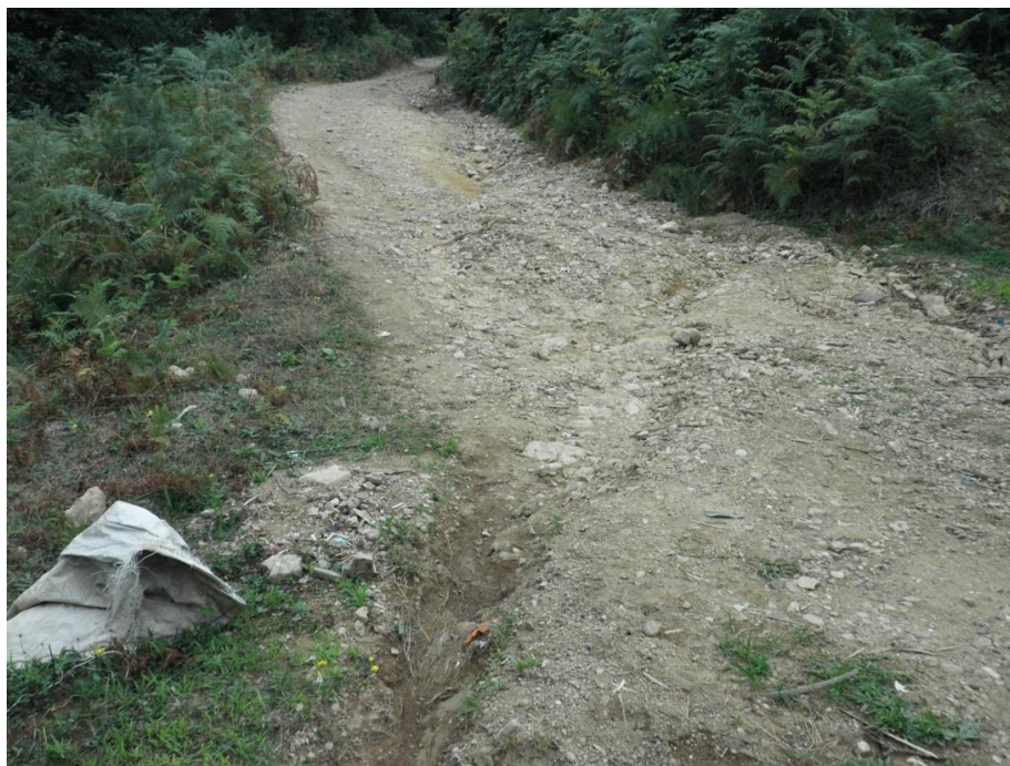
Фото заглиблення на поверхні дороги, яке виконує функцію водовідведення, але на випадок інтенсивних опадів необхідно збільшити його глибину.
