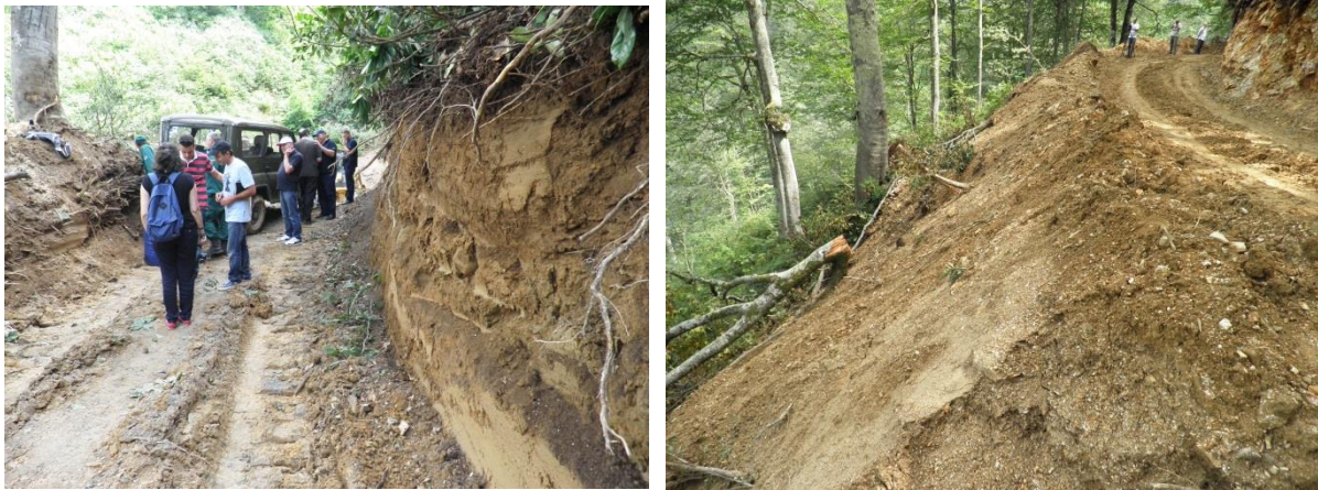
Вертикальний профіль відкосу і насип з боковою засипкою – будівництво нової дороги в Аджарії, виїмки, які з часом ймовірно будуть спричиняти проблеми
